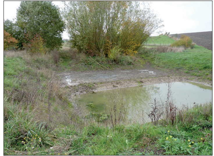
Bassin de décantation/filtration en sortie de drainage. (source CDA Moselle)
