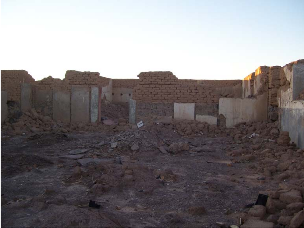
6. Vista interior de pulpería.
