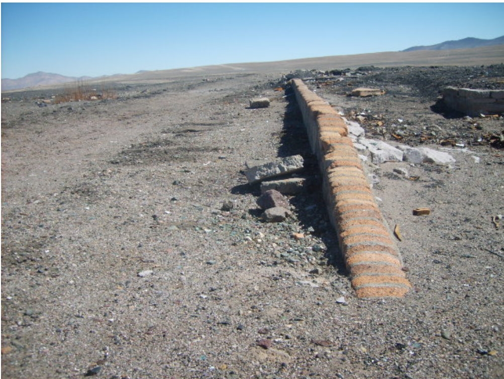
17. Estación Refresco. Nótese improntas de durmientes féreos.
