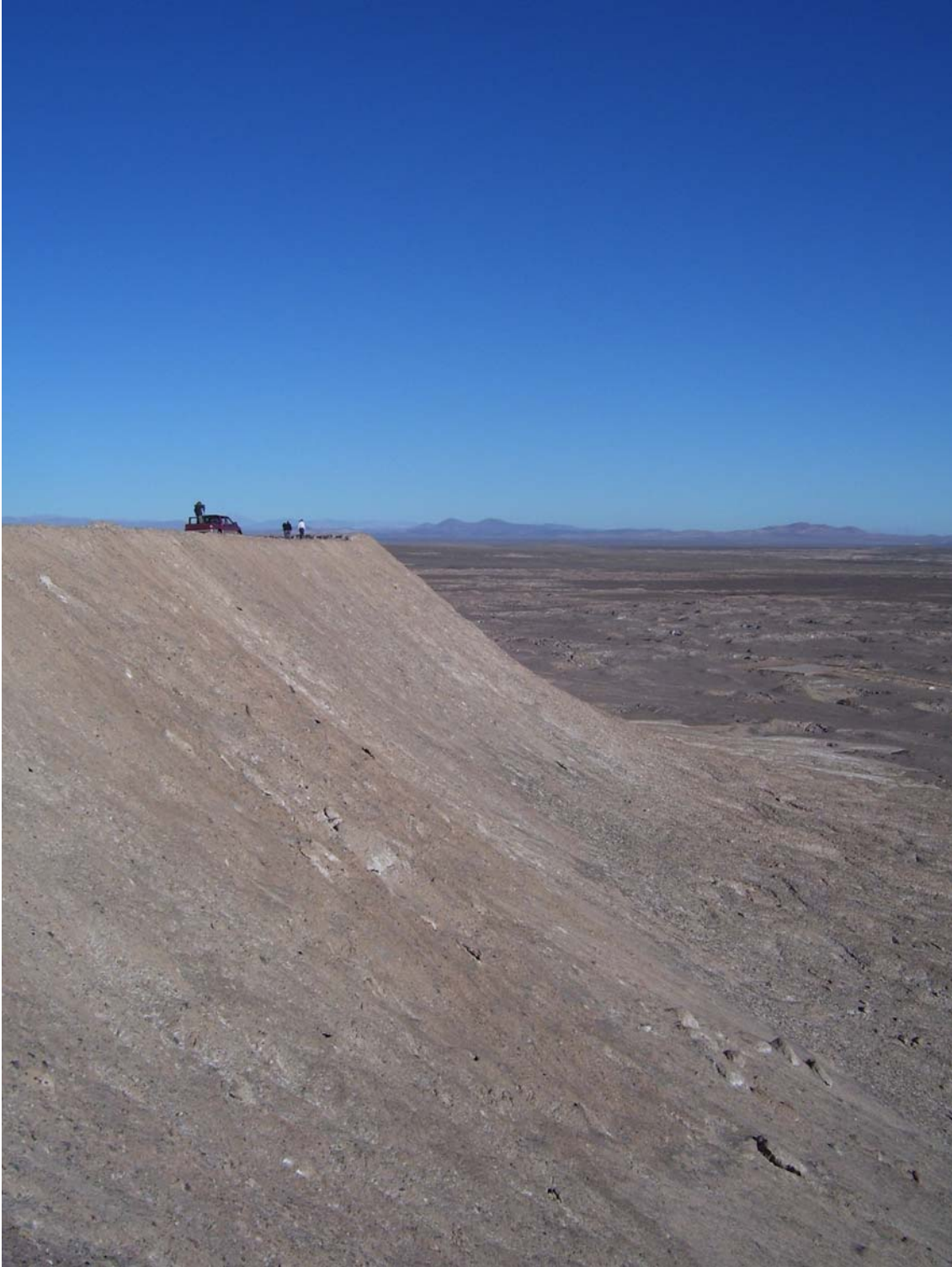
20. Vista general de torta de relaves.
