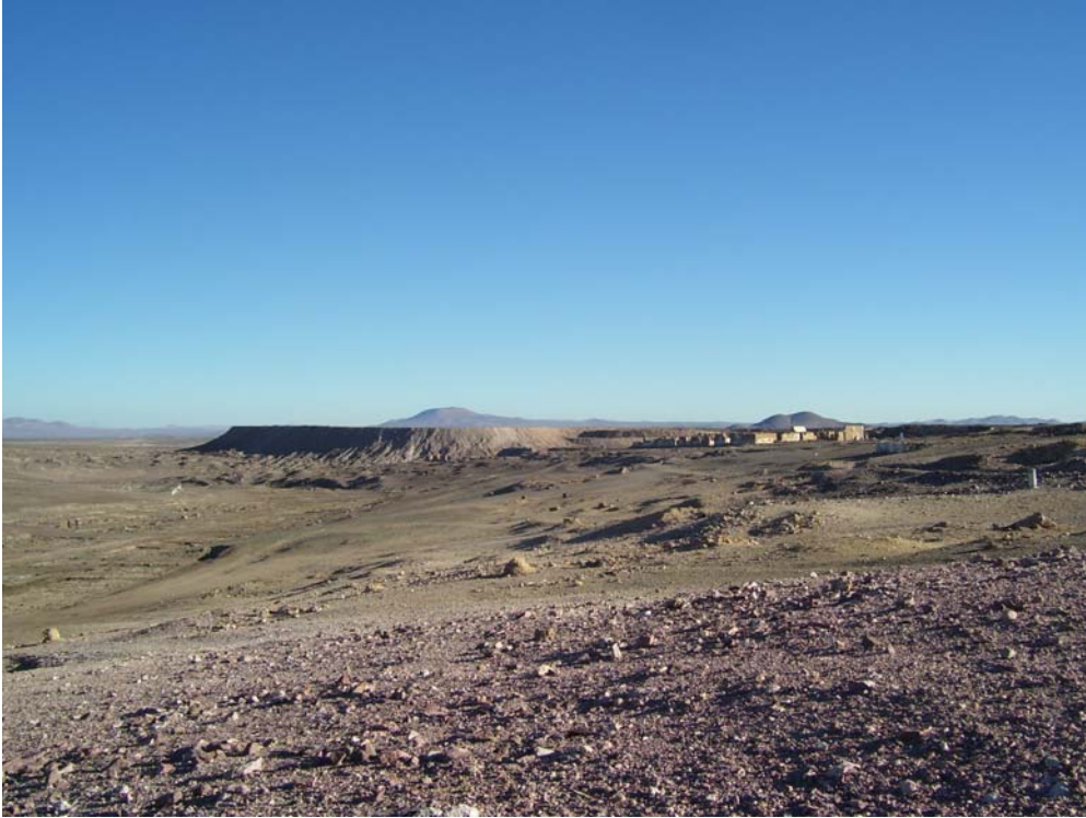
4. Vista general de oficina Flor de Chile. Se observa la construcción administrativa, y la torta de desechos productivos.
