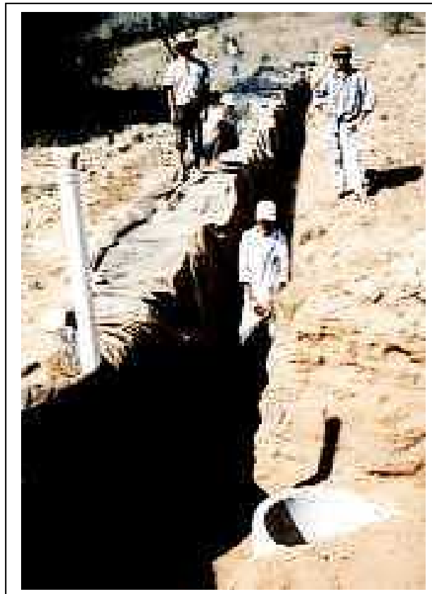
Figure 4 : construction d'un barrage souterrain
