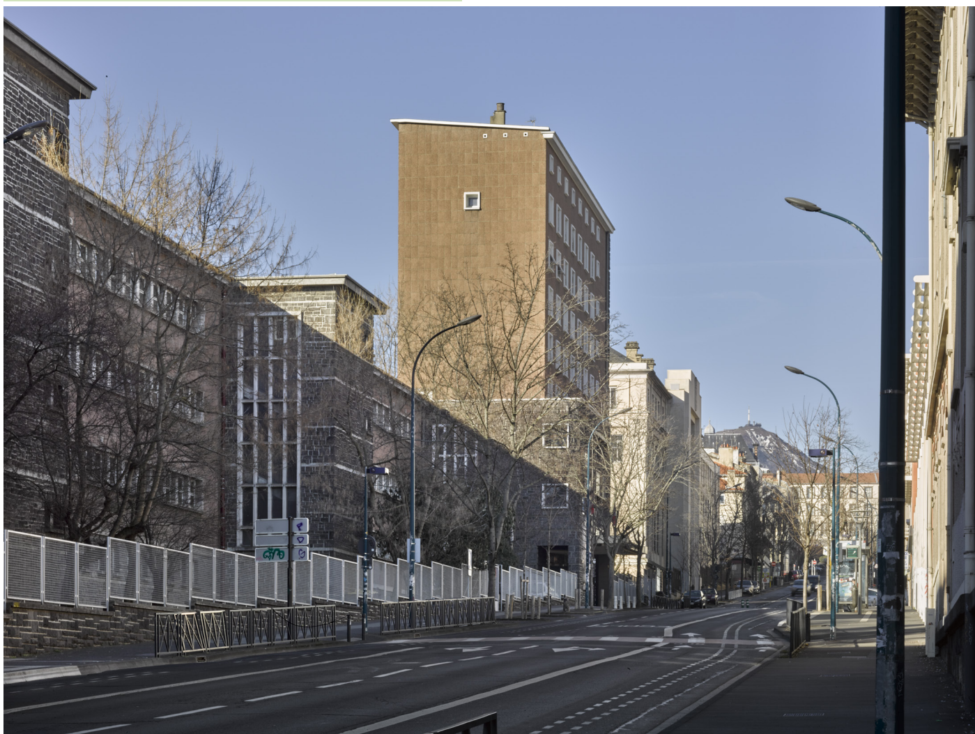
Fig. 8 : Clermont-Ferrand (Puy-de-Dôme), 36, avenue Carnot. Lycée Blaise-Pascal, 1953-1955. Depuis le bas de l'avenue Carnot vers l'est. On peut noter d'une part la ressemblance du bâtiment du premier plan avec une enceinte médiévale, et d'autre part la liaison visuelle existant entre le lycée et le puy de Dôme.
