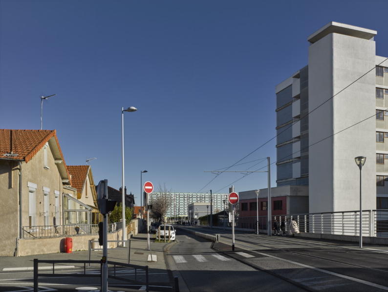
Fig. 6 : Clermont-Ferrand (Puy-de-Dôme). Rue du Docteur-Bousquet. À droite, lycée Ambroise-Brugière. Les bâtiments sont « groupés à l'angle le plus élevé de la parcelle, offrant des vues dégagées à l'ouest et au sud » et cherchant à « briser la monotonie du paysage de banlieue environnant » (la barre que l'on voit dans le fond est postérieure à la construction du lycée). La cage d'escalier faisant tour, ajoutée au projet d'origine, accentue cet effet.
