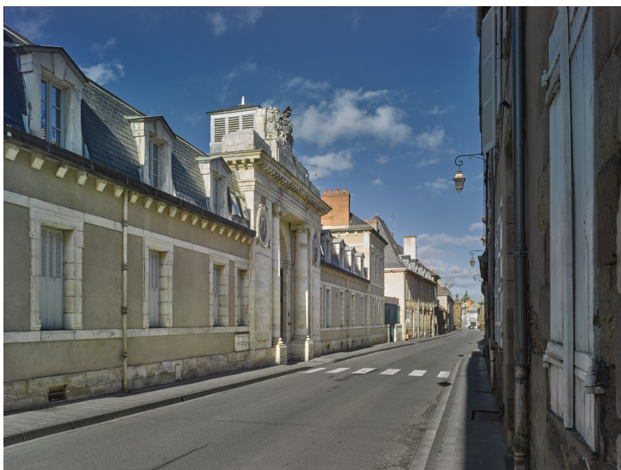
Fig. 10 : Moulines (Allier). Rue de Paris. Lycée Théodore-de-Banville : premier lycée aménagé hors de Paris, en 1802-1804, dans un ancien couvent de visitandines (progressivement démoli, remplacé par des bâtiments neufs dans la seconde moitié du XIXe siècle). Au premier plan, porche monumental offert par le préfet. À l'arrière-plan on distingue la porte de ville.
