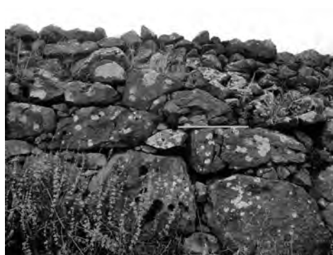
Fig. 7 — Détail du mur de fortification, tronçon sud (cl. L. Phialon).
