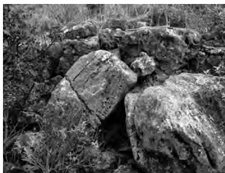
Fig. 8 — Détail du mur de fortification, tronçon ouest (cl. L. Phialon).
