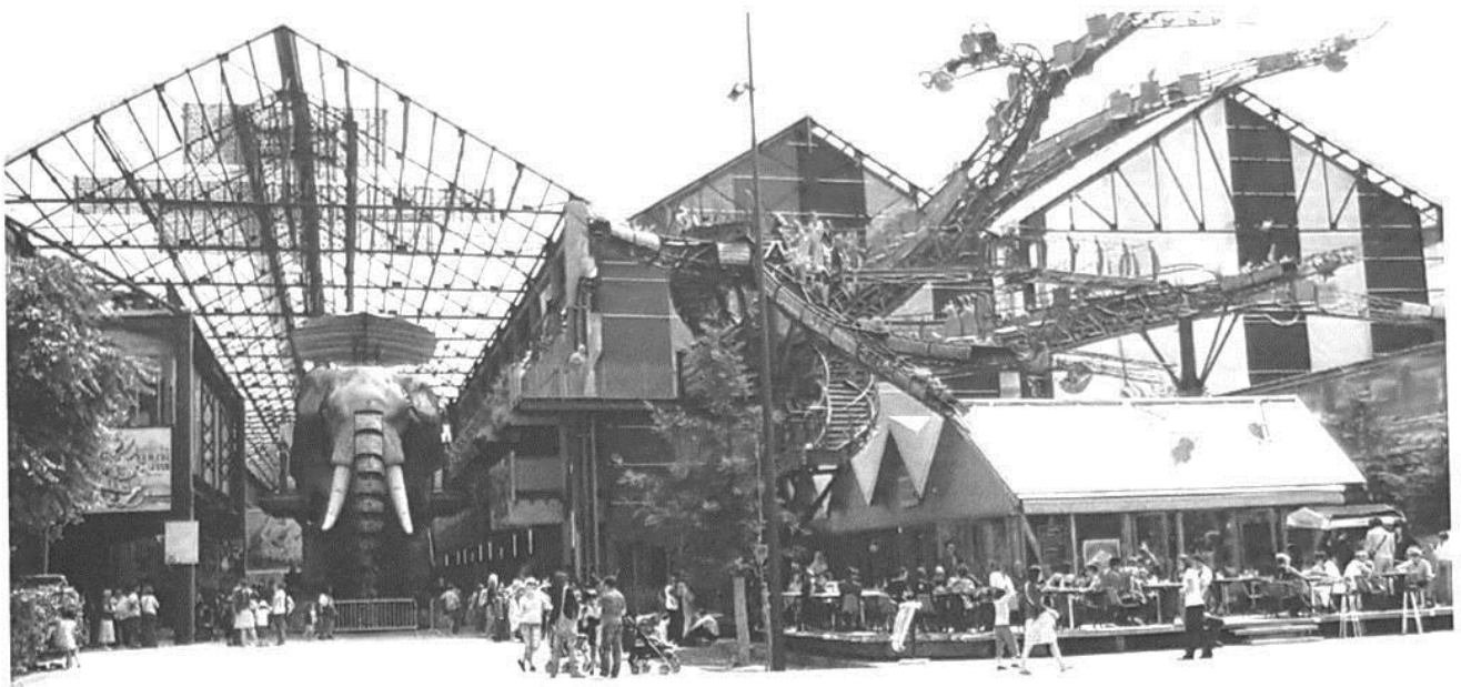
Fig. 6.- Nantes, Ile de Nantes, les nefs réhabilitées des chantiers navals et l'Eléphant, cliché Jean-Louis Kerouanton 2008.
