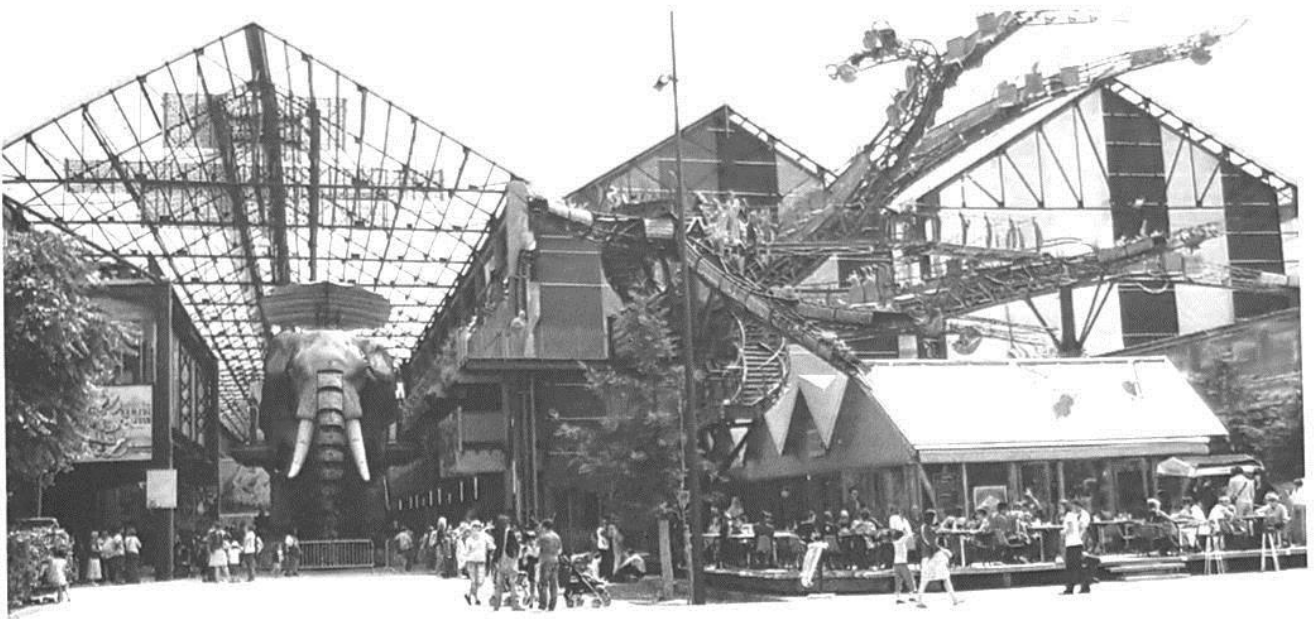
Fig. 6.- Nantes, Ile de Nantes, les nefs réhabilitées des chantiers navals et l'Eléphant, cliché Jean-Louis Kerouanton 2008.
