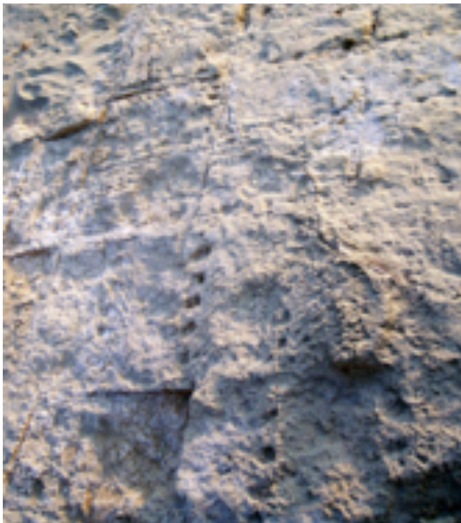
Fig. 15. Plancher de carrière à trame orthogonale dans la carrière de Pyrgos (photo S. Müller Celka).
