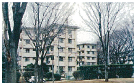
Immeubles publics des années 70...
