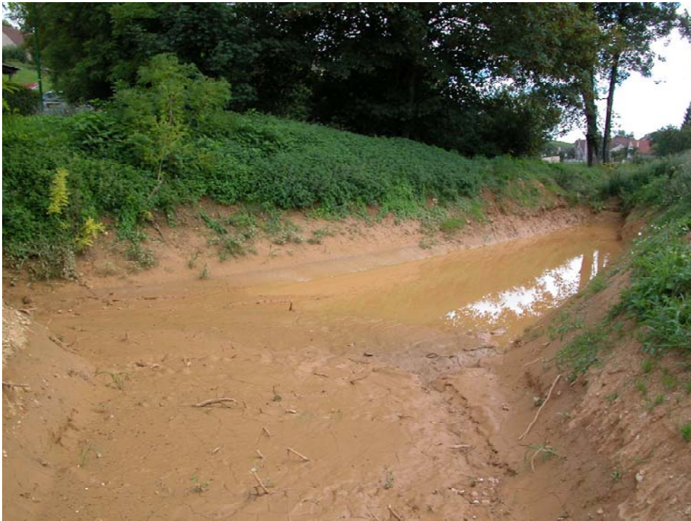
Figure 3. Bac de récupération et de décantation des eaux chargées en argiles, creusé en bas de versant (Pernand-Vergelesses, août 2006)
