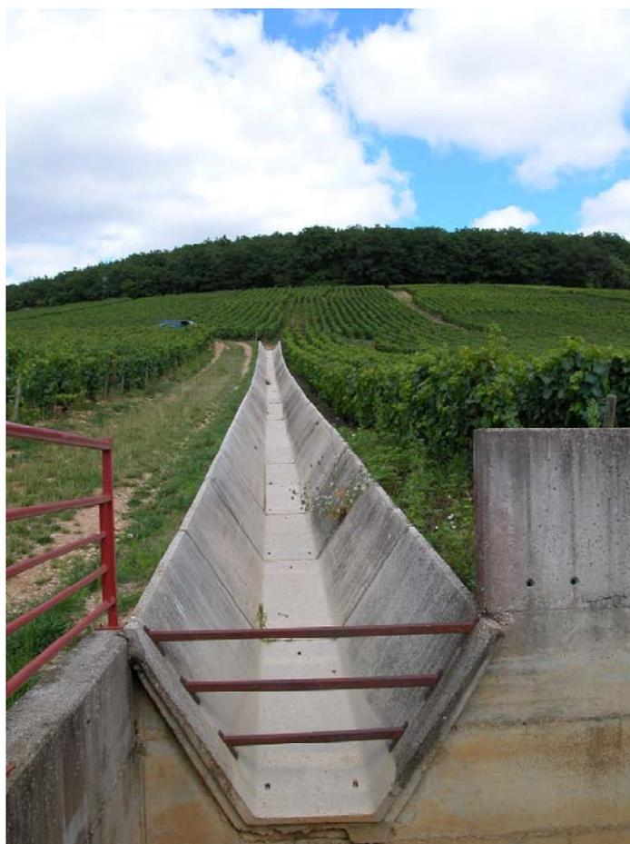
*Figure 4. Ravine bétonnée aménagée en collecteur des eaux chargées en sédiments (Corton, août 2006)*
