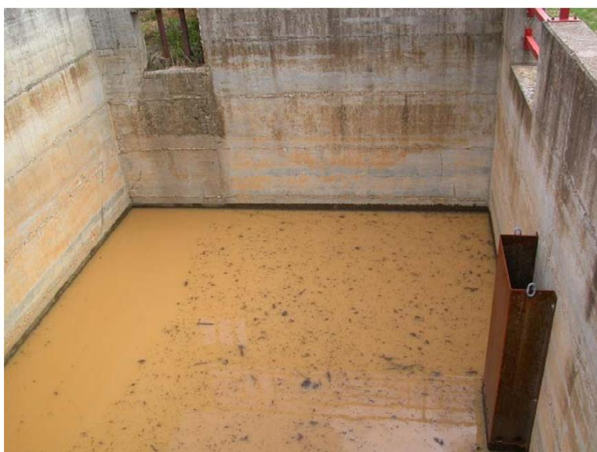
*Figure 5. Bac bétonné de récupération et de décantation des eaux chargées en sédiments, aménagé à mi-versant (Corton, août 2006)*
