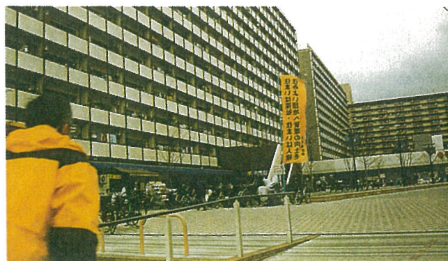
TOSHIMA GO CHOME : grand ensemble sur dalle de très haute densité construit en 1973 dans la banlieue nord de Tôkyô. Manifestation contre la hausse des loyers générée par les rénovations.
