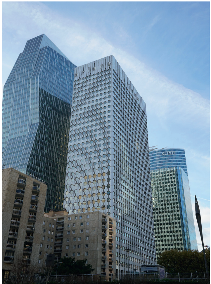
► Fig. 7. La tour PB13, automne 2017 (© Léo Noyer-Duplaix/ La Manufacture du Patrimoine).
