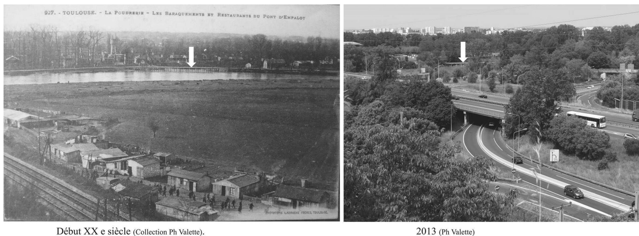
Figure 2 : L'urbanisation de la vallée de la Garonne : exemple d'Empalot au Sud de Toulouse The urbanization of the Garonne Valley: example of Empalot (south of Toulouse)
