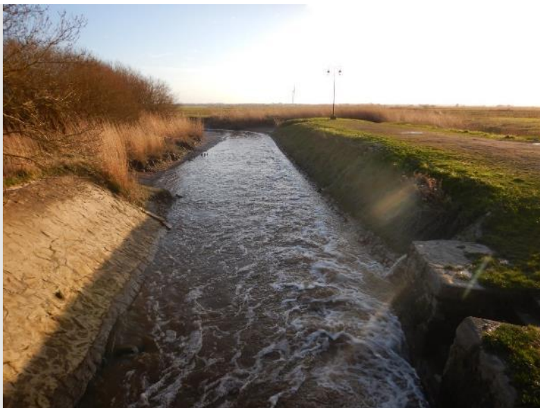
Photographie 28 : perrés et quais du port de Lavau-sur-Loire, 2019. © Anatole DANTO.
