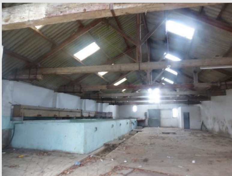
Photographie 29 : Ancienne civellerie à Paimboeuf, rue Pitre Chevalier. A gauche, les anciens bacs à civelles, 2014. © Anatole DANTO.
