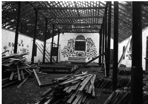
Reconstrucción de la Iglesia de Solentiname. 2011.
