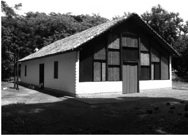
Reconstrucción de la Iglesia de Solentiname. 2011.
