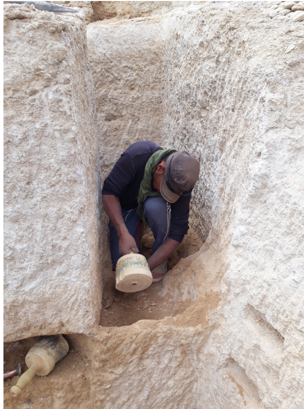
Fig. 17. Position du carrier à l'intérieur de la tranchée.
