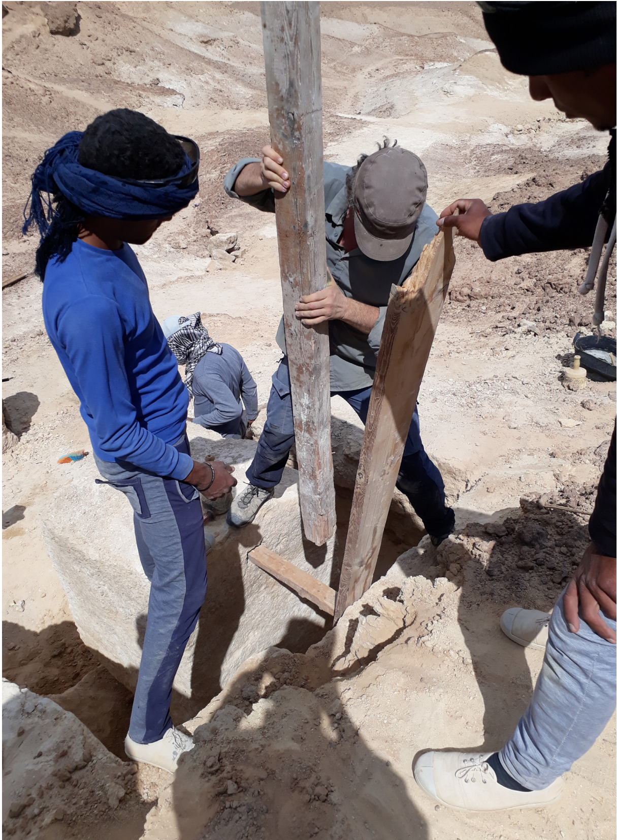
Fig. 19. Mise en compression d'un buton en bois à l'arrière du bloc pour opérer la rupture, c'est-à-dire le détachement de son banc.
