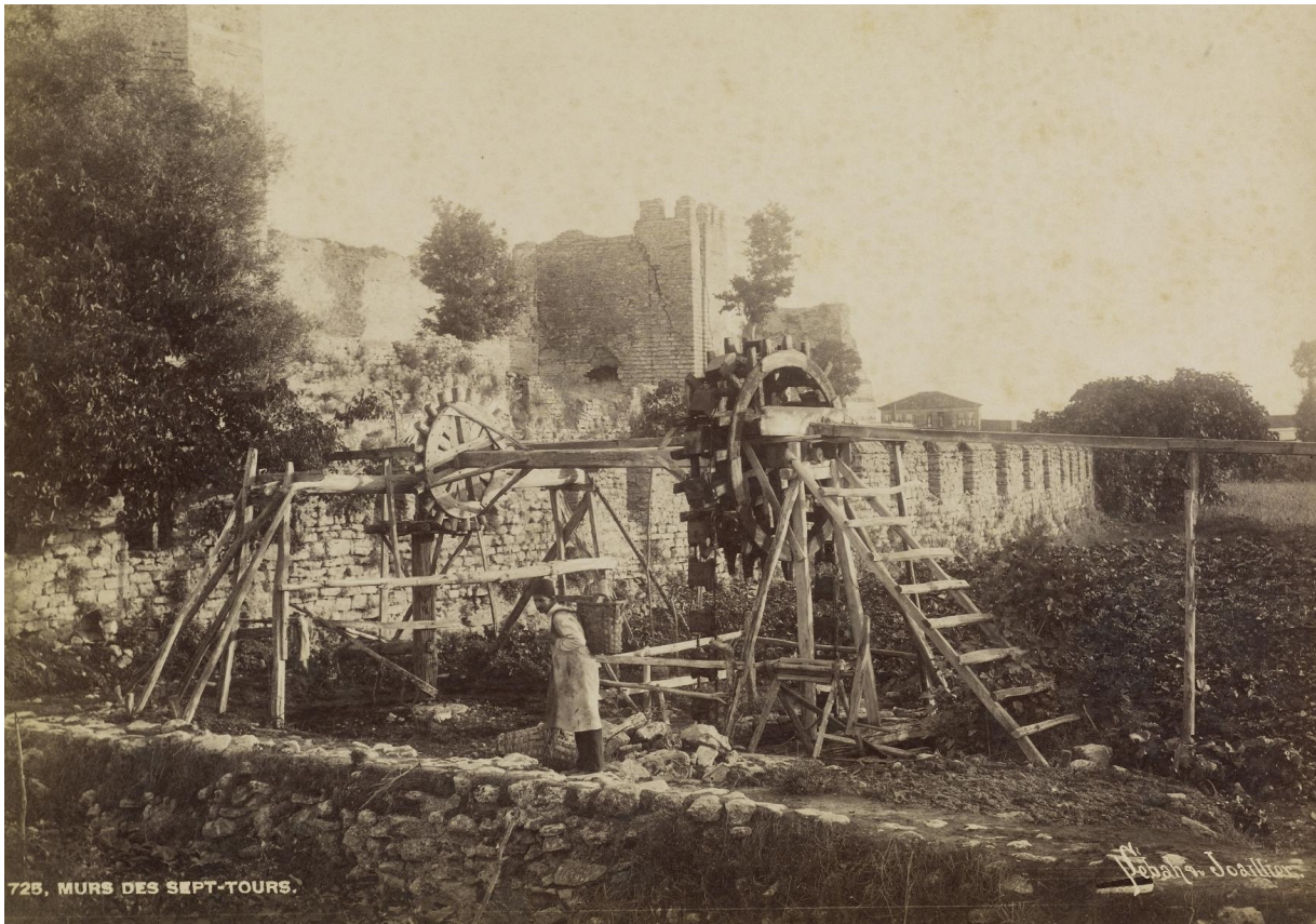
1. Extraction d'eau autour d'un puits historique dans les bostan de douve (Sébah et Joaillier, 1880)
