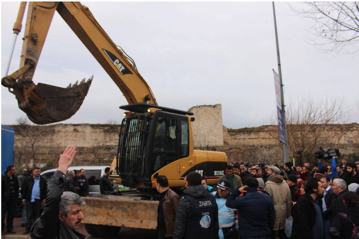
27. Occupation de l'espace au moment de la destruction des cabanes des bostan de douve ( XXI Mimarlık , 2016)
