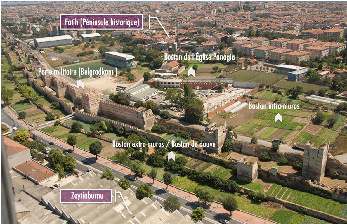
13. Vue aérienne des murailles terrestres retravaillée par l'auteure (Municipalité de Grand Istanbul, 2005)
