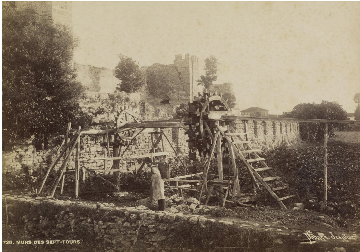
1. Extraction d'eau autour d'un puits historique dans les bostan de douve (Sébah et Joaillier, 1880)
