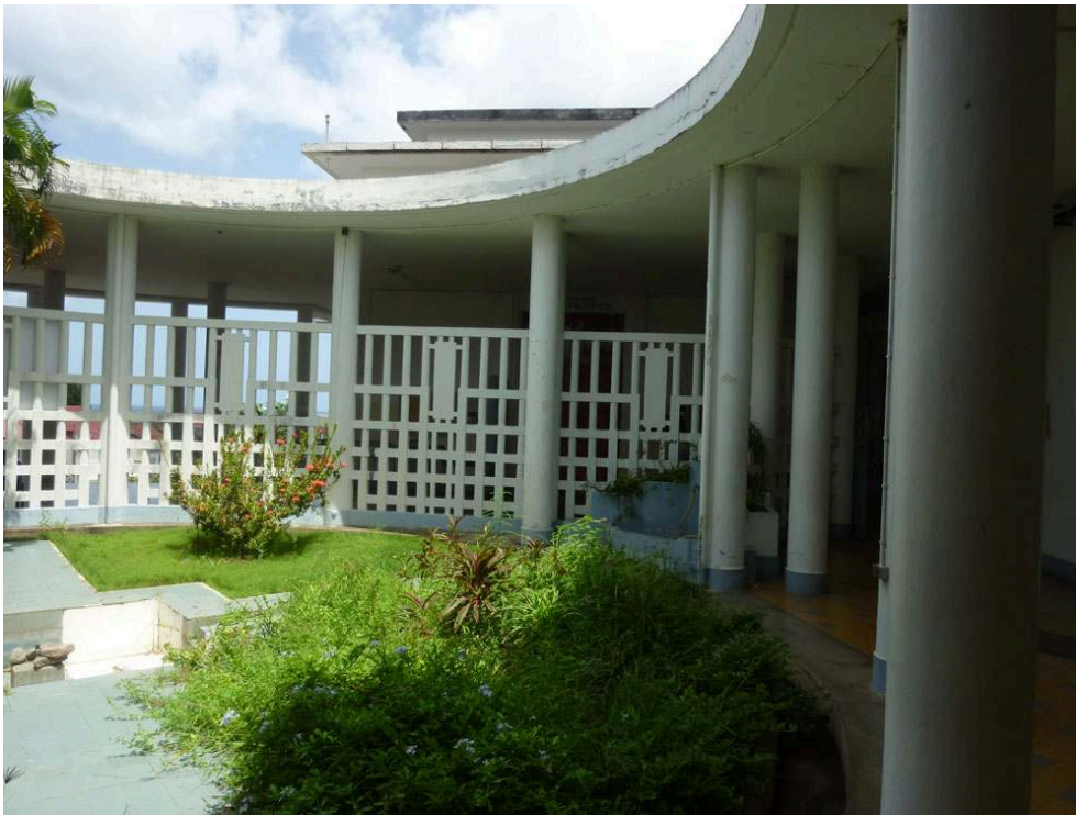
Figure 6 : Ali Tur, patio du palais du de justice, Basse-Terre, Guadeloupe (France), 1931-1934.
