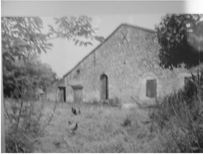
Exemple de mur pignon en façade à Blésignac (Cl. Maffre 80.33.520 X)
