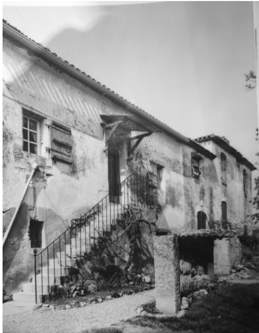
Mur gouttereau en façade à Hanx (Cl. Dubau 86.33.790 V)
