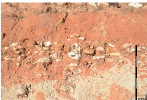
3 - Coupe artificielle le long de la route menant au Château
