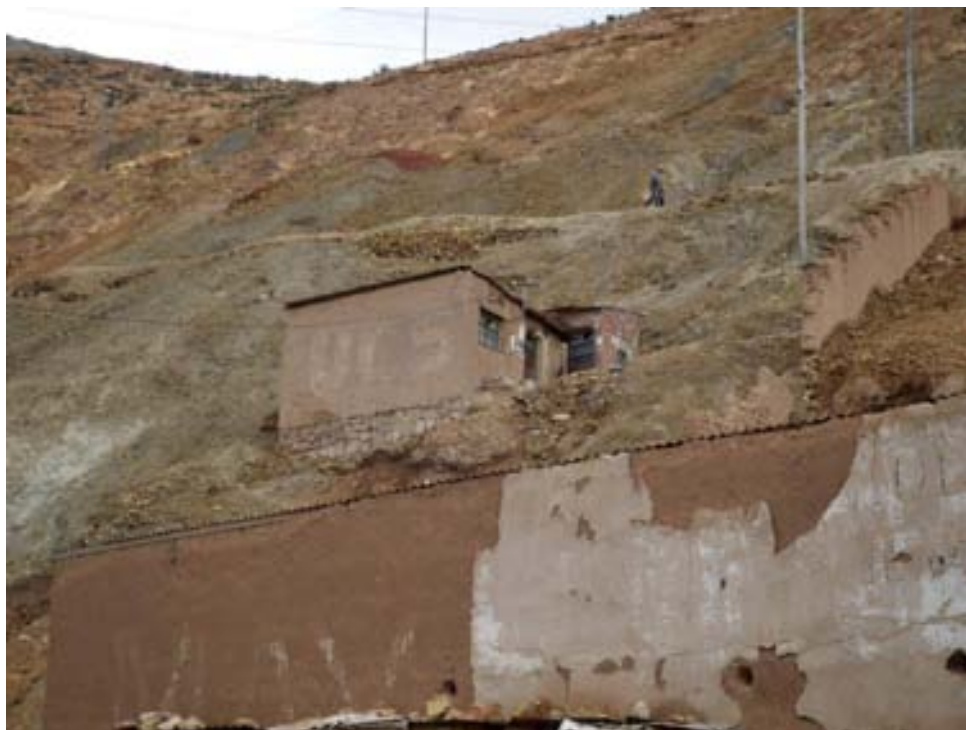
Construcción "legal" sobre un terreno cedido por la COMIBOL en los años 90, hoy en día constituido por rellenos de desechos mineros
