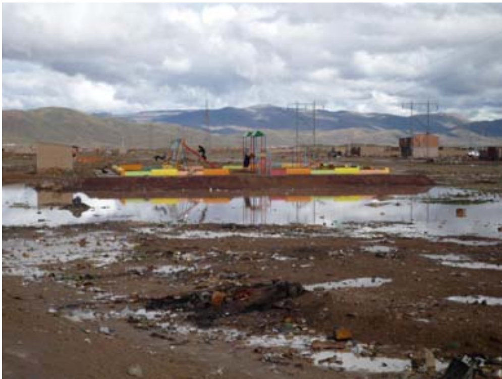
Una infraestructura de juegos para niños en la zona de Sora, en el distrito 4, al medio de las frecuentes inundaciones y de la basura. Se puede apreciar el talud y el elevado dónde se ha construido la infraestructura, prueba del conocimiento del problema de drenaje de la zona.
