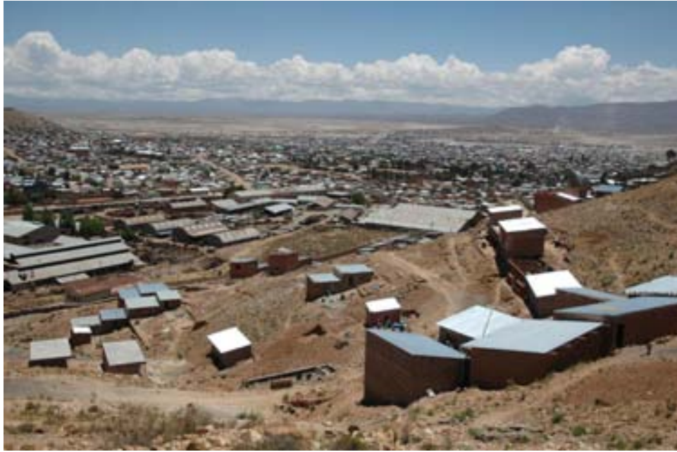
La población se asienta poco a poco encima de los desmontes, tanto en San José como aquí, o en San Miguel. Esta instalación se hace sin tratamiento ni preparación especial del suelo.
