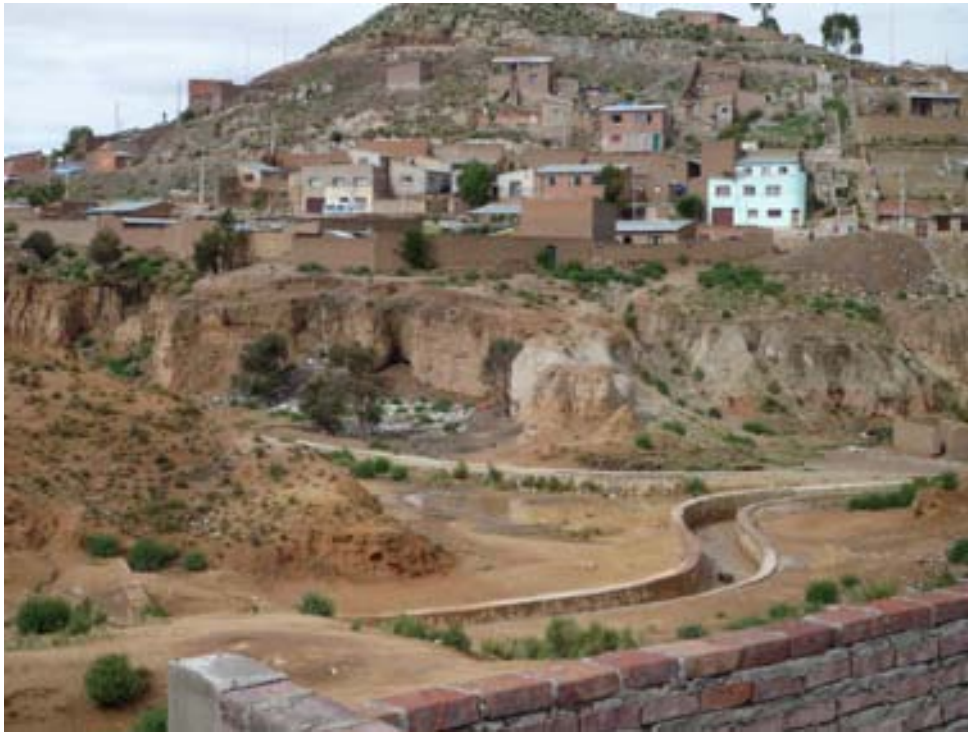
Existe un sistema muy importante de canales dentro de los cerros que tiene como función colectar las aguas de copagira y permitir un mejor drenaje. Hoy en día la mayoría de estos canales no están conectados al sistema minero y sirven principalmente de basurero.
