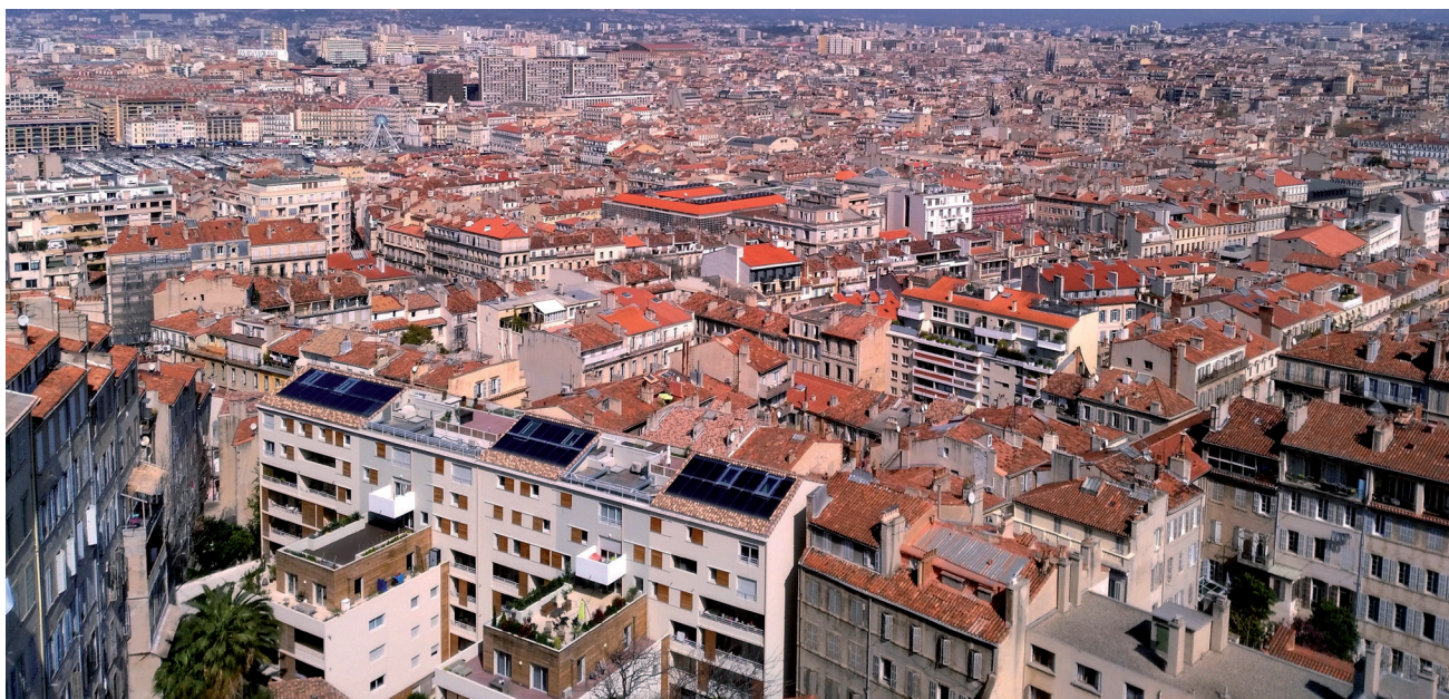
Photo 11. Le caractère minéral de la ville (Marseille)
