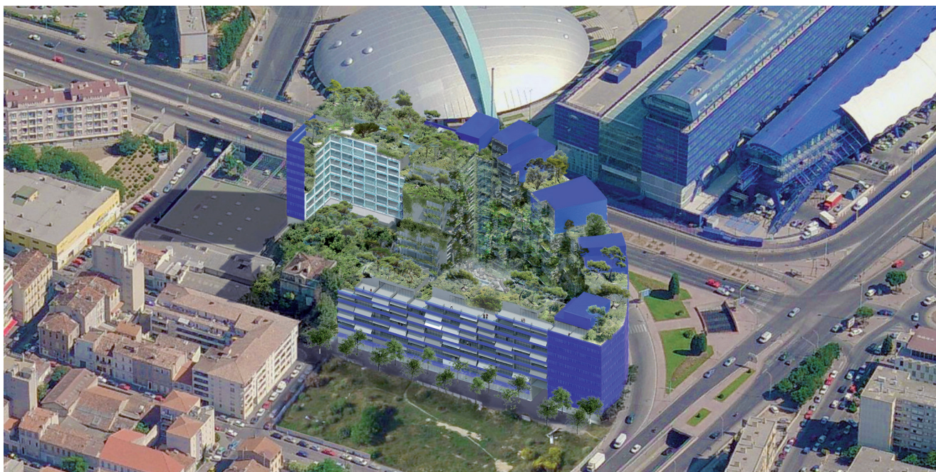
Figure 20. Projet de logements de Jean Nouvel dans le quartier Saint-Just à Marseille : cœur d'îlot, terrasses et façades abondamment végétalisées 34
