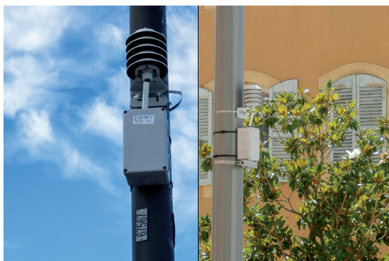
Photo 3. Dispositifs de suivi des températures et de l'humidité sous abri à Marseille dans le cadre d'une campagne de mesures estivales
