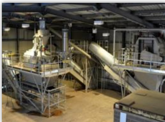
Figure 3.4 : Centre de production des granulats carbonatés. Carbon8 Aggregate. Brandon, UK
