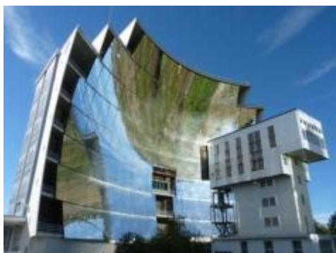
Figure 3.7 : CSP2 : récepteur solaire à lit fluidisé (PROMES, Odeillo)
