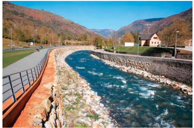
Fig. 17 – Chenalisation de la Garonne à Lès (Val d'Aran), 31 octobre 2014
