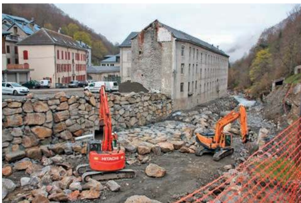
Fig. 18 – Perroyage du lit du Bastan à Barèges (Hautes-Pyrénées), 22 avril 2014
