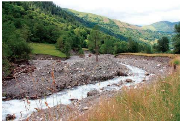
Fig. 2 – Érosion latérale, incision et alluvionnement de la Neste d'Oô à Oô
