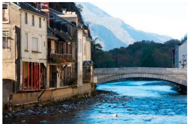
Fig. 19 – Façades éventrées à Saint-Béat (Haute-Garonne), 16 mois après la crue, 31 octobre 2014
