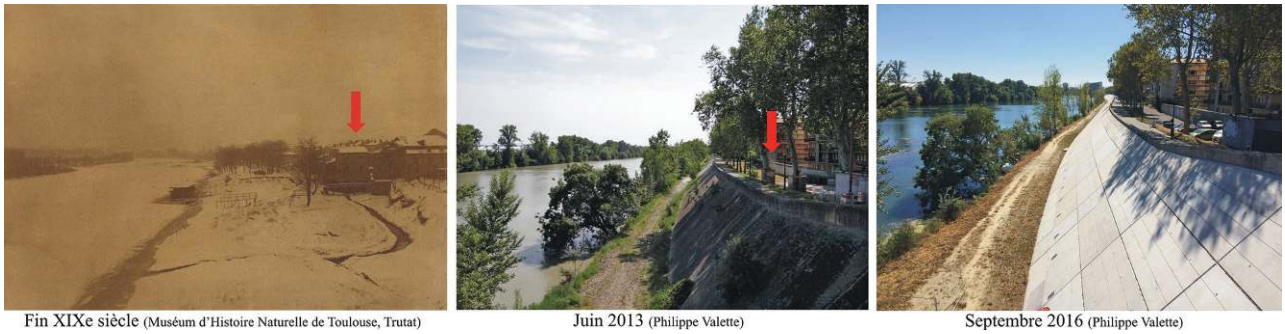
Fig. 4 – Évolution des paysages fluviaux urbains en amont du pont Saint-Michel entre la fin du XIX e siècle et aujourd'hui. Le moulin Vivens disparaît au profit de la construction de digues en béton, qui ont été confortées en 2014-2015
