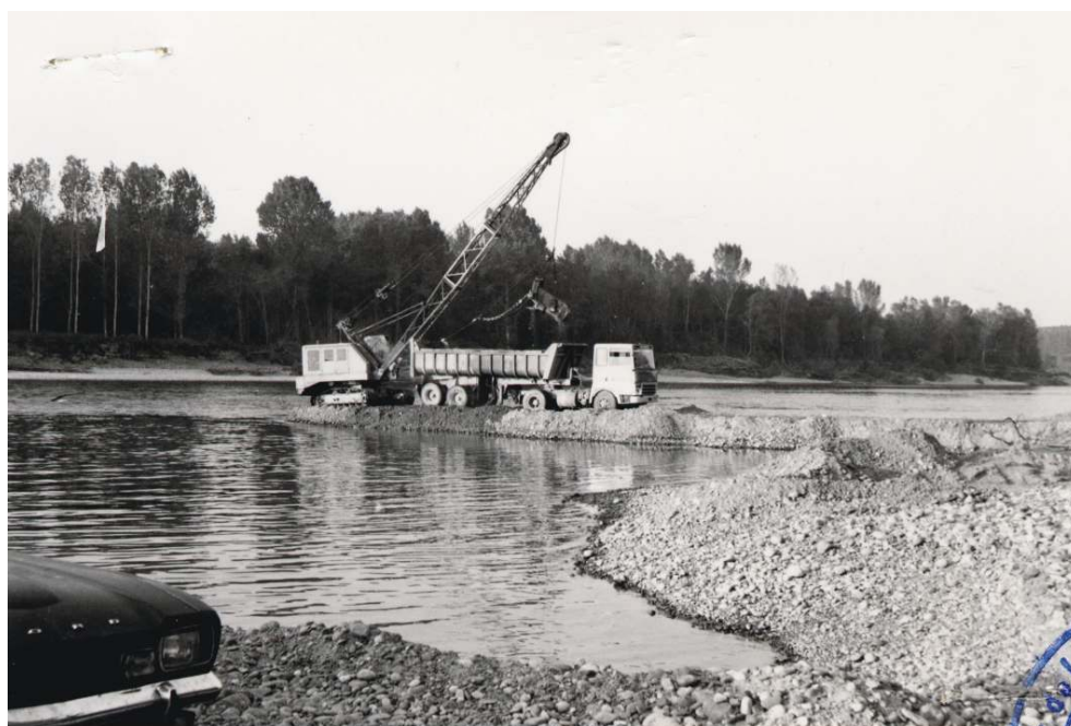
Figure 7. L'extraction de granulats en lit mineur
