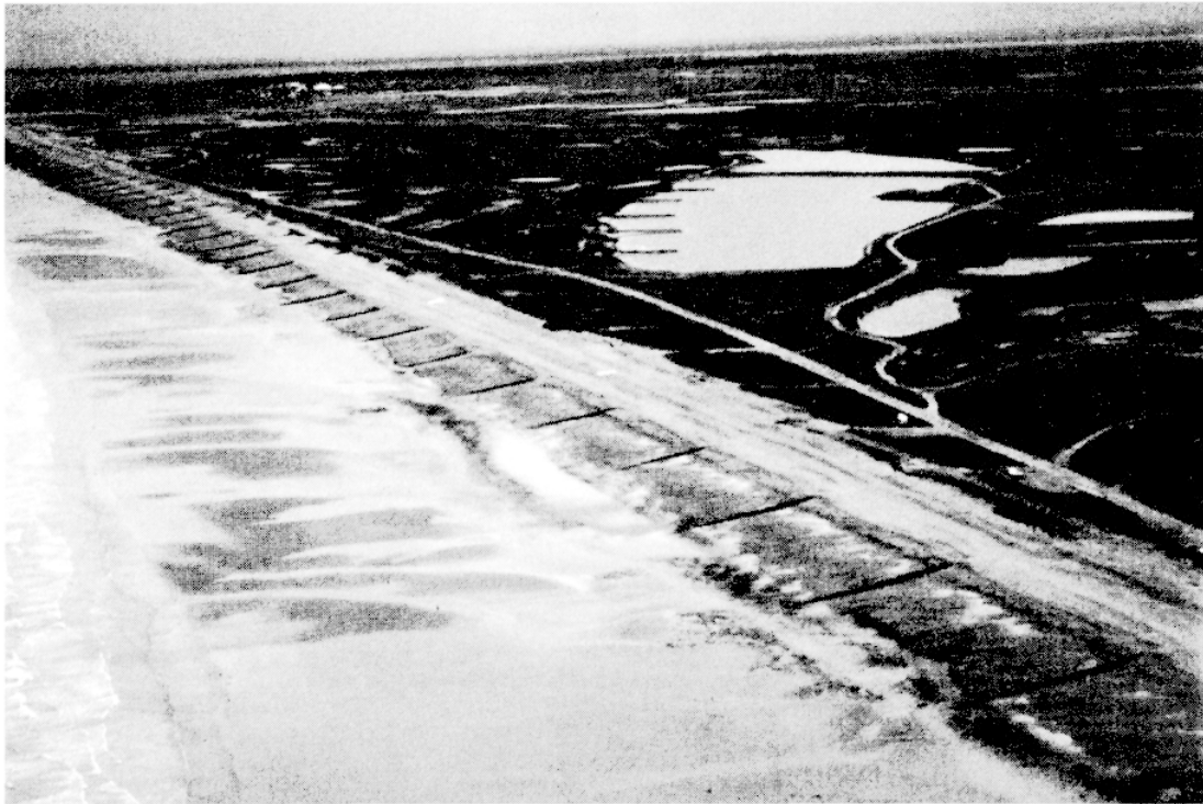
Photo 1 - Secteur proximal (secteur 1, fig. 2) de la flèche en érosion. Ce secteur est défendu aujourd'hui par une batterie d'épis et par des rechargements en galets.
