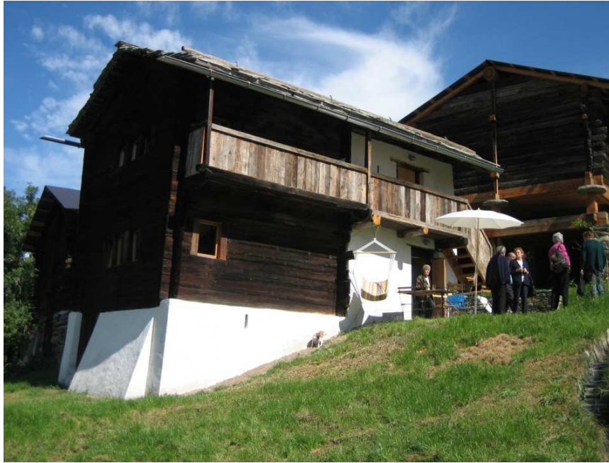
Fig. 1 : Les maisons rénovées à Ossona (© Mathieu Petite 2008)
