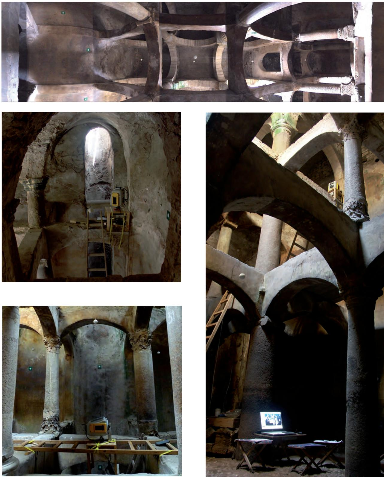
Fig. 7. Différents outils mis en œuvre pour l'acquisition tridimensionnelle de la citerne : cibles et sphères, "chevalet", équerre.
