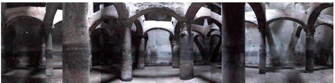
Fig. 6. Vues panoramiques de la citerne : la couverture, les niveaux supérieur, intermédiaire et inférieur de l'intérieur de la cuve. Cl. L. Borel © CEALex.
