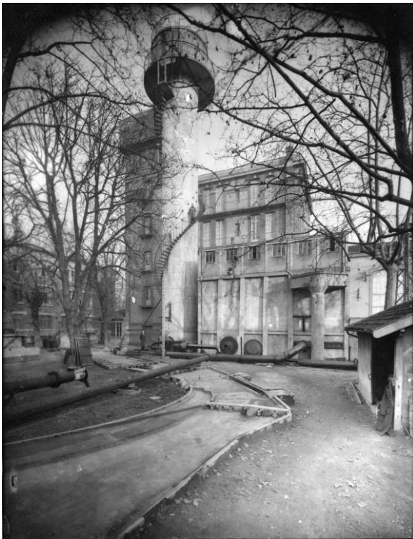
Figure 2 [fichier ArchCra_CourIET.jpg] - Dans la cour de l'IET, modèle réduit de la Garonne et du Pont-Neuf à Toulouse. Les modèles réduits seront transférés sur le site de Banlève à partir de 1920.
