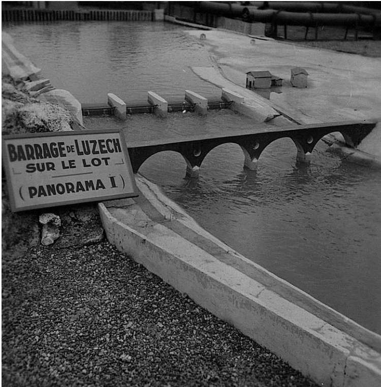
Figure 12 [fichier 11_20b_Luzech.jpg] - Modèle réduit d'un ouvrage hydraulique sur le "laboratoire plat" de l'IMFT, vers 1950.
