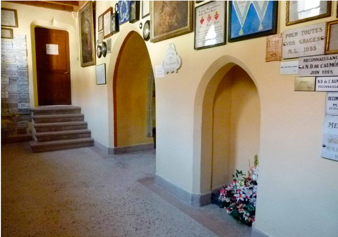
Fig. 4 – Mur gouttereau nord de la chapelle médiévale, ancienne porte condamnée à droite et ancien enfeu ou chapelle à gauche. Cl. S. Bochaton
