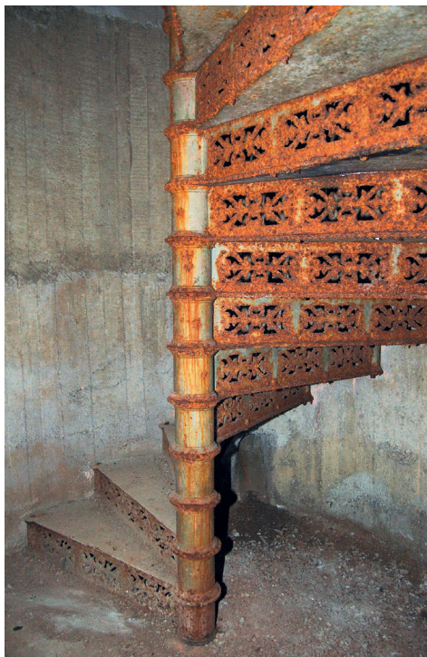
FIG. 57. Escalier métallique appartenant au casino «Jetée-Promenade» de Nice retrouvé en réemploi dans un réseau souterrain creusé par l'armée allemande au pied de la colline du château. Cliché A. Grandieux.
