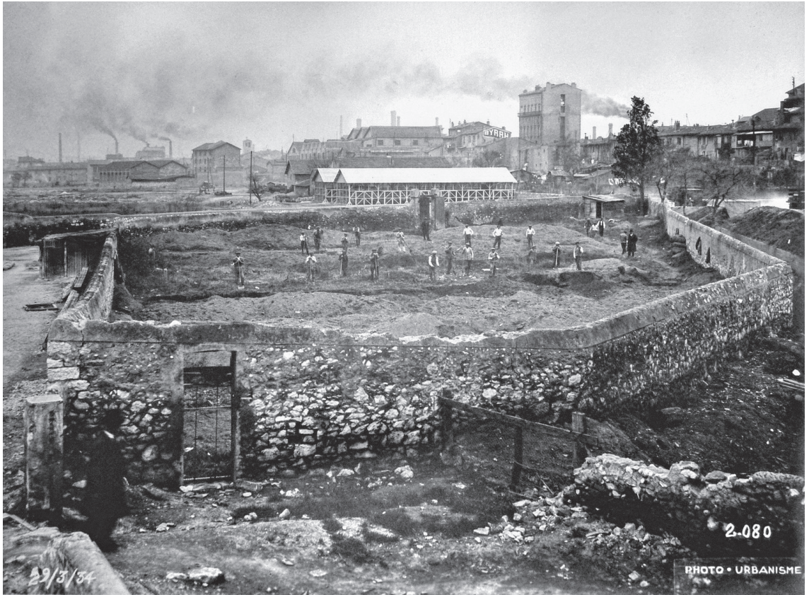
FIG. 38. Photographie montrant la purge du cimetière des « Petites Crottes » à Marseille (Bouches-du-Rhône) en 1934. Archives municipales de Marseille 439W75.
