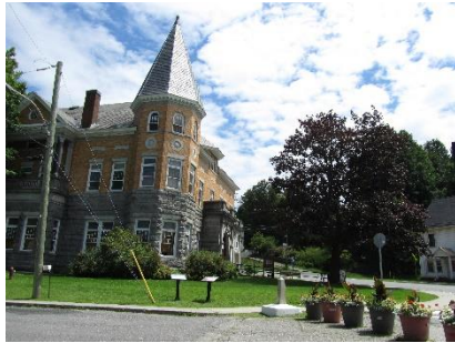
Fig 2 : exemples de bâtiments « construits » sur la frontière. La frontière est délimitée par une borne blanche et par des pots de fleurs. (source : P-A. Beylier, 2017)
