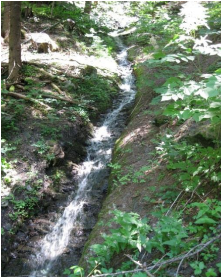
Figure 23: Canal de l'Arc à Montrigon, ancienne section empierrée, Bourg-Saint-Maurice, 27/6/12 (cliché B. Meilleur)
