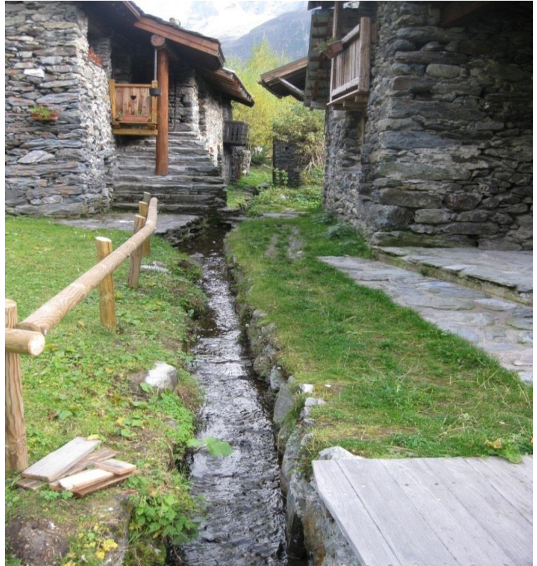
Figure 25: Canal de drainage, Laisonnay d'en Bas, Champagny, 6/10/12, (cliché B. Meilleur)
