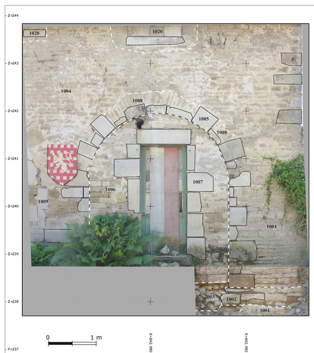
Fig. 11 – Orthophotographie du pan de mur occidental de la façade nord du Logis de Broyes et numérotation des unités construites
