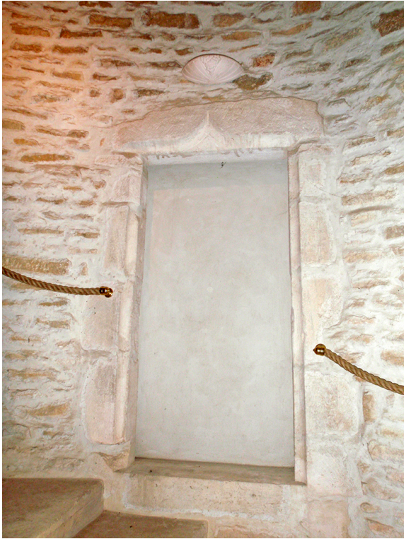
Fig. 9b – Exemple d'une autre porte bouchée dans l'escalier de la tour de l'Auditoire et donnant sur le Logis de Broyes
