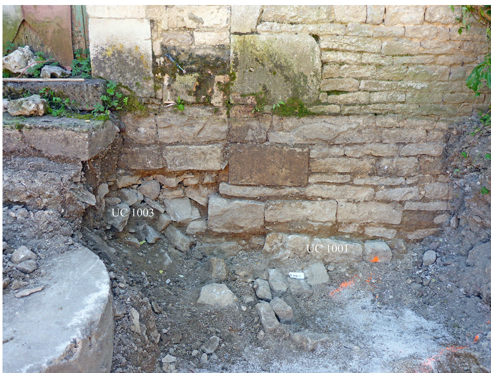
Fig. 10 – Vue de la maçonnerie 1001 et de la zone de vide comblée par le bouchage UC 1003
