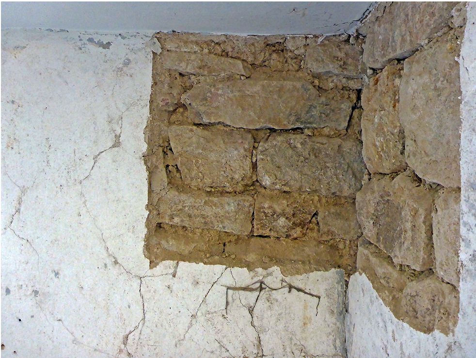
Fig. 6b – Vue de la maçonnerie UC 2006 dans le sondage 11 de la pièce 2
