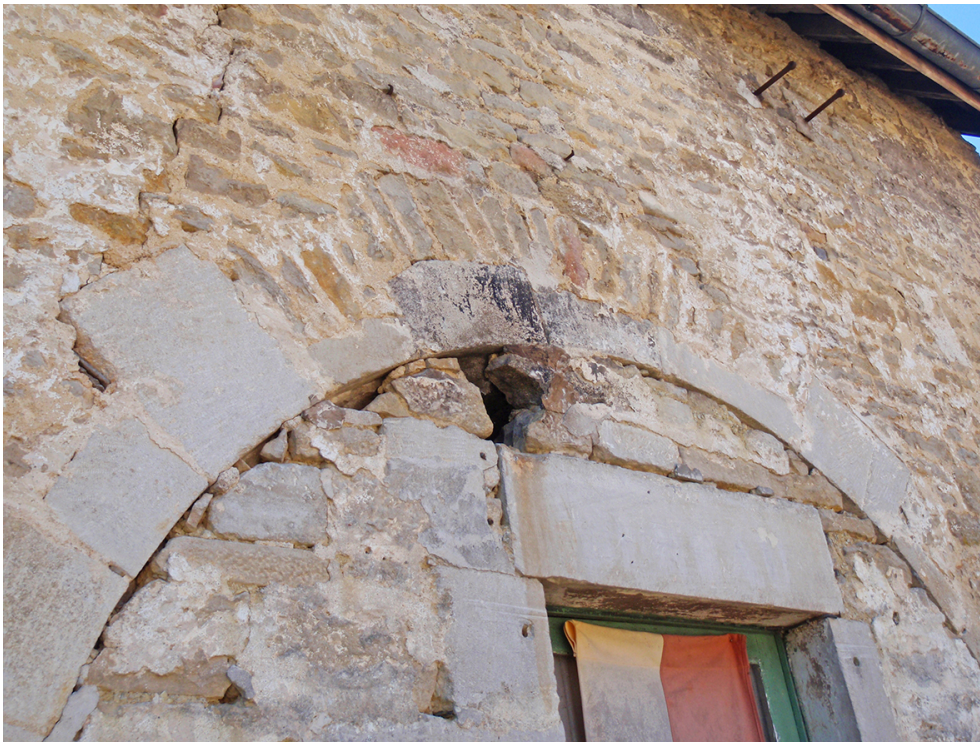
Fig. 12 – Détail des blocs posés de chant complétant les claveaux en pierre de taille de l'arcade 1005
