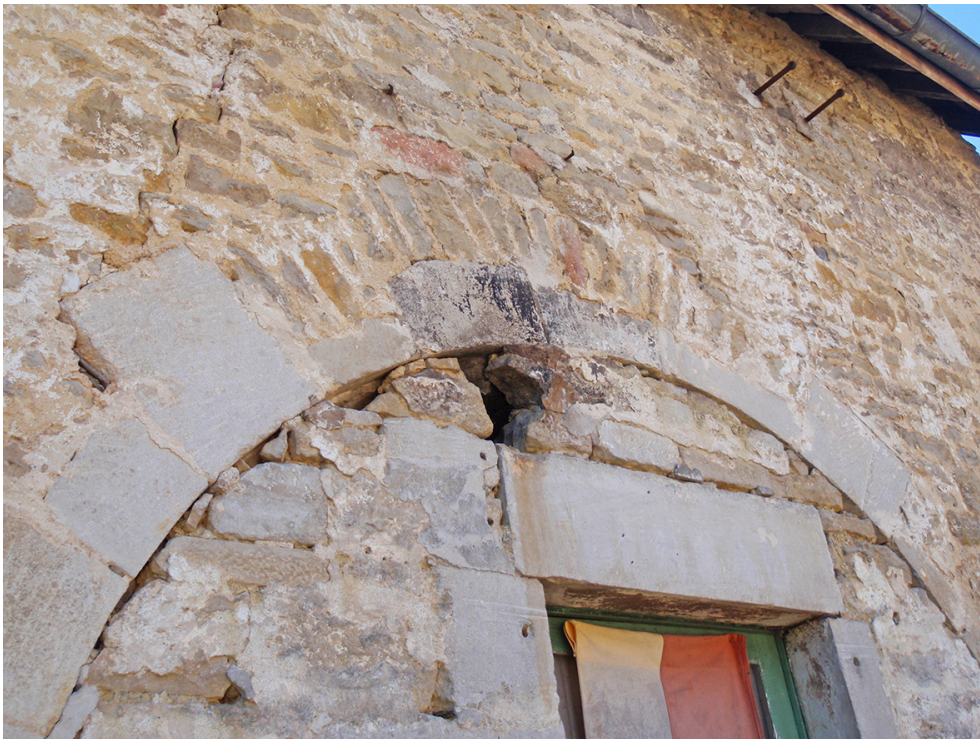
Fig. 12 – Détail des blocs posés de chant complétant les claveaux en pierre de taille de l'arcade 1005
