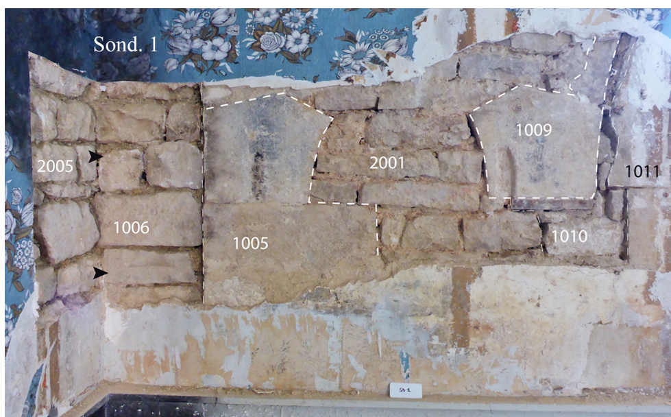
Fig. 14 – Vue des différentes unités construites du sondage 1, pièce 1
