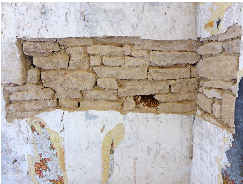
Fig. 6c – Vue de la maçonnerie UC 2006 dans le sondage 12 de la pièce 2
