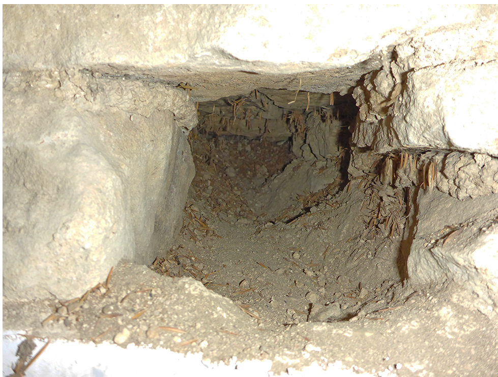
Fig. 15b – Vue du trou de boulin UC 2016 dans lequel on distingue les restes de paille après bouchage
