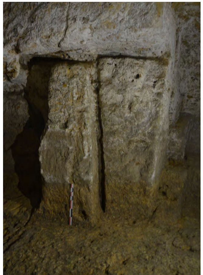
Fig. 21 - Vue générale des BN 38 et 39
