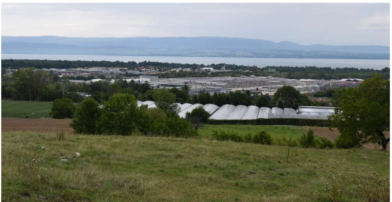
Fig. 27- L'usine de la SAEME à Amphion-les-Bains.
