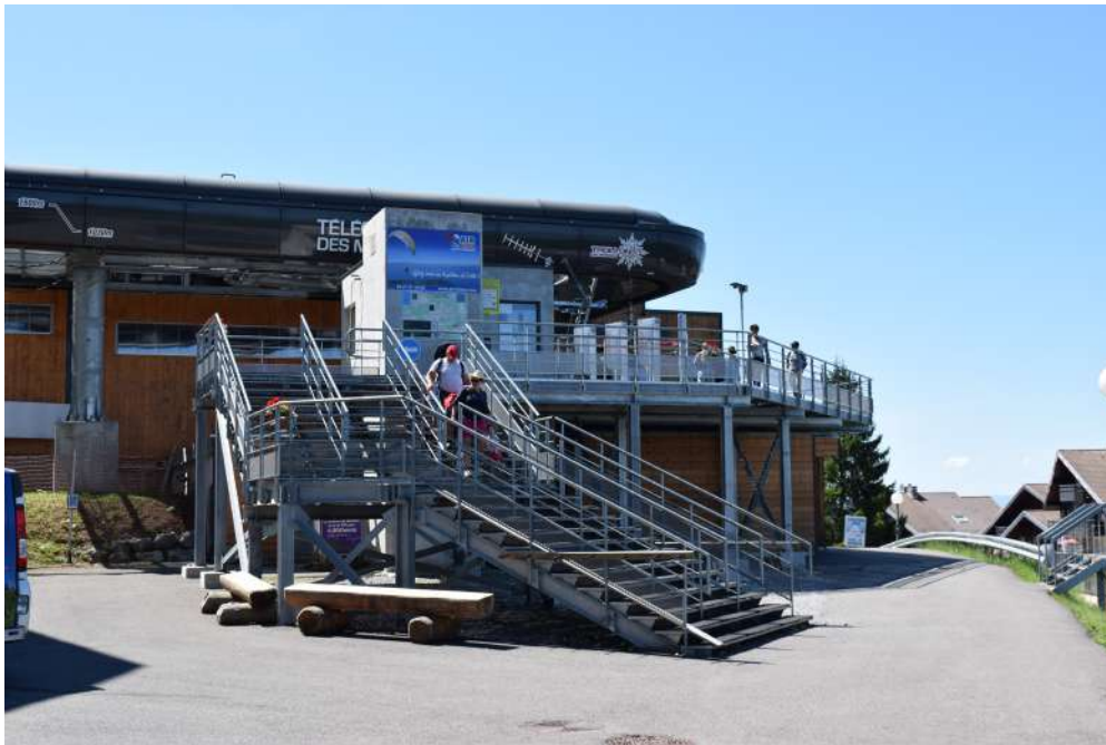
Fig. 28- Départ de la nouvelle télécabine de Thollon-les-Mémises.
