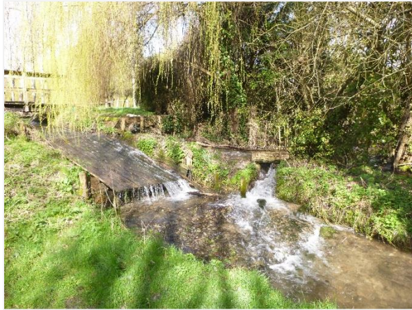
Déversoir de dérivation au lieu-dit La Nivelles / Meung-sur-Loire
