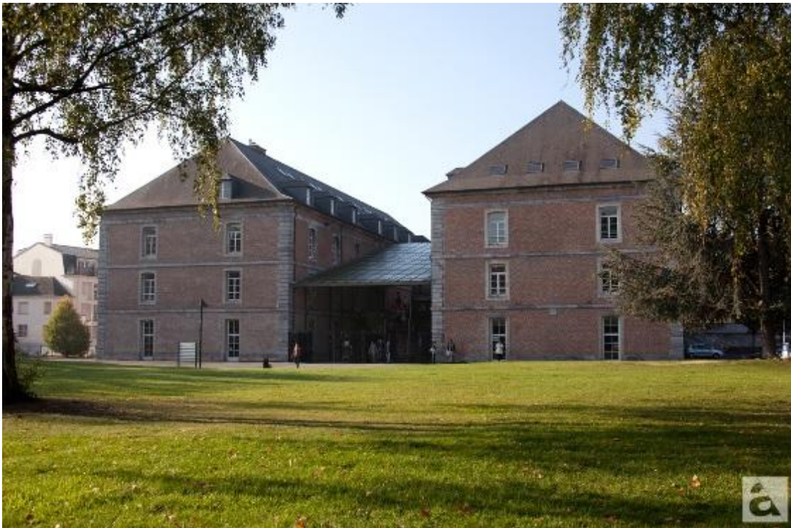
fig.1 La Caserne Ronzier, département Art, Bibliothèque et restaurant de l'Université Polytechnique, Hauts-de-France.
