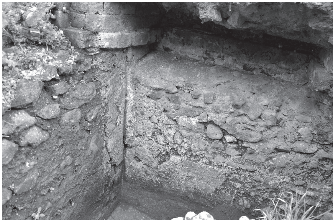
Fig. 2 – Area Sacra di largo Argentina. Particolare della vasca 5 in cui è visibile che l'impianto idrico si appoggia alla fondazione del contropodio del tempio B.
