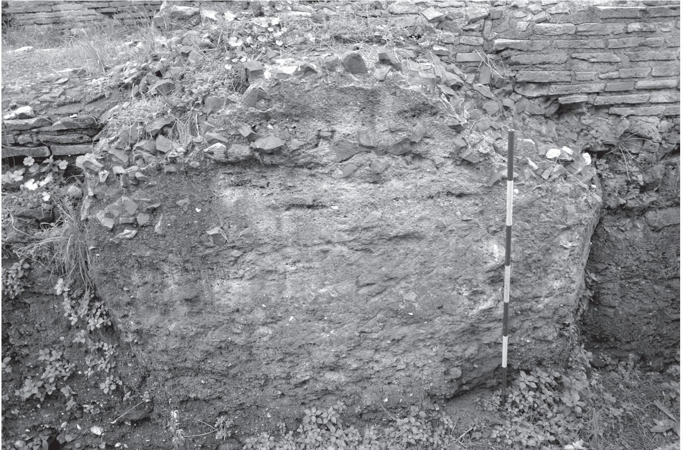
Fig. 10 – Area Sacra di largo Argentina. Particolare del conglomerato cementizio (vasca 3) utilizzato nella costruzione delle vasche mistilinee 1-3.
