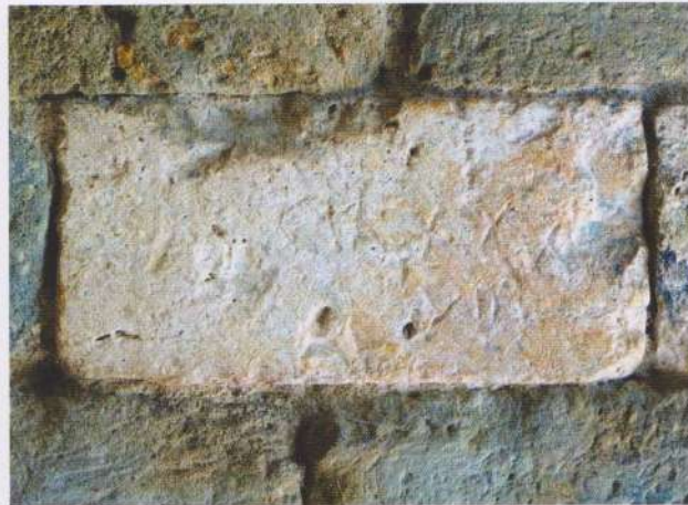
Fig. 26. Gimont. Abbaye de Planselve. Porterie. Inscription gravée sur le mur sud en face du silo B (photo M.-T. Tinet-Lassure)
