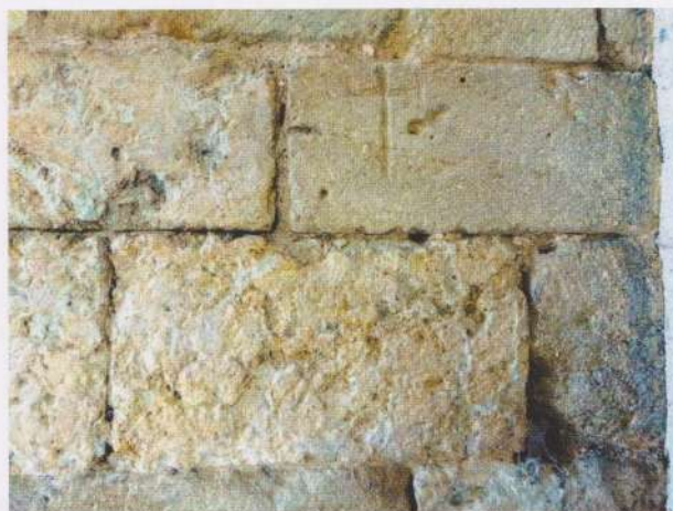
Fig. 22. Gimont. Porterie de l'abbaye de Planselve. Inscription CXXXXX et croix pattée sur le mur nord, en face du silo A (photo M.-T. Tinet-Lassure)
