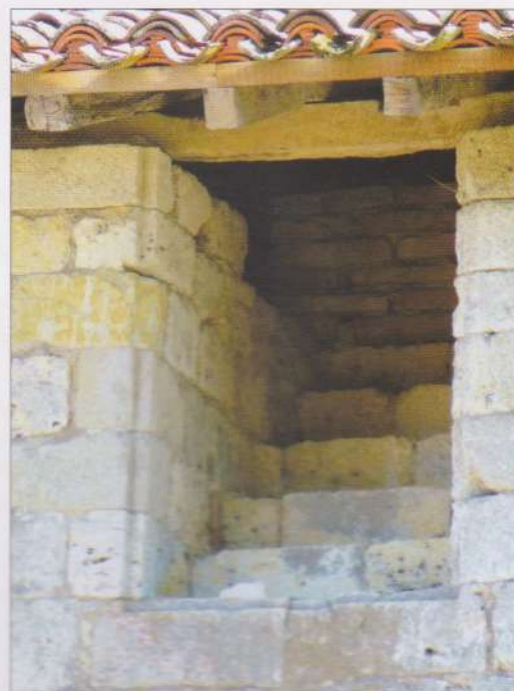
Fig. 4-5. Gimont. Abbaye de Planselve. Porterie. Vestiges d'une porte située sur la face nord du bâtiment et d'un escalier en pierre qui conduisait à un étage (photos M.-T. Tinet-Lassure)
