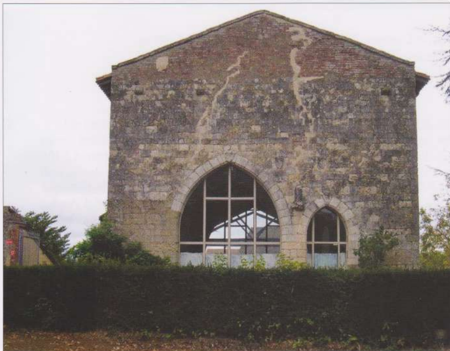
Fig. 2.- Gimont. Abbaye de Planselve. Façade de la porterie (photo M.-T. Tinet-Lassure)
