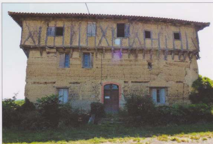
Fig. 29. Juilles. Grange de l'abbaye de Planselve. Façade nord. (photo M.-T. Tinet-Lassure)
