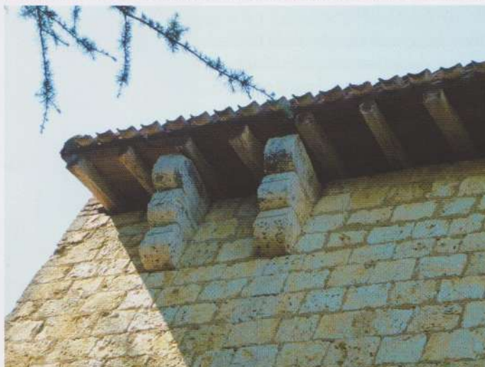
Fig. 6. Gimont. Abbaye de Planselve. Porterie. Corbeaux destinés au soutien de latrines (photo M.-T. Tinet-Lassure)
