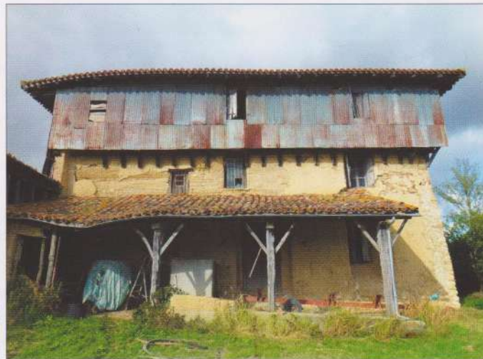
Fig. 31. Juilles. Grange de l'abbaye de Planselve. Façade sud. (photo M.-T. Tinet-Lassure)
