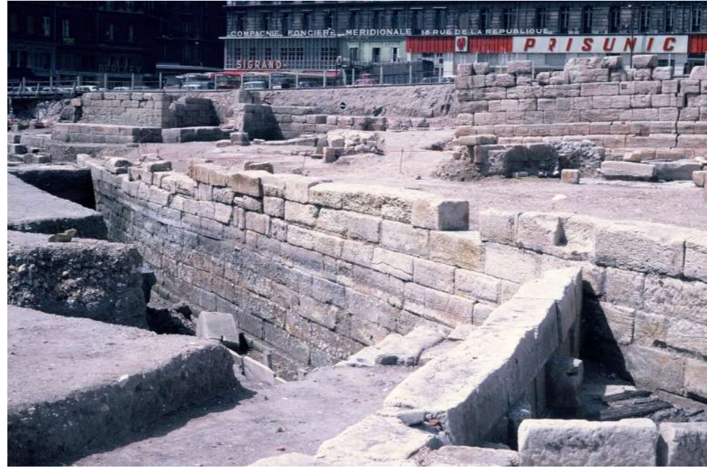
Fig. 2 - Site de la Bourse - corne du port : quai ouest, 1968. Élévation entièrement dégagée de la face interne, en contact avec l'eau. © photo Antoine Chenet / CNRS-CCJ.
